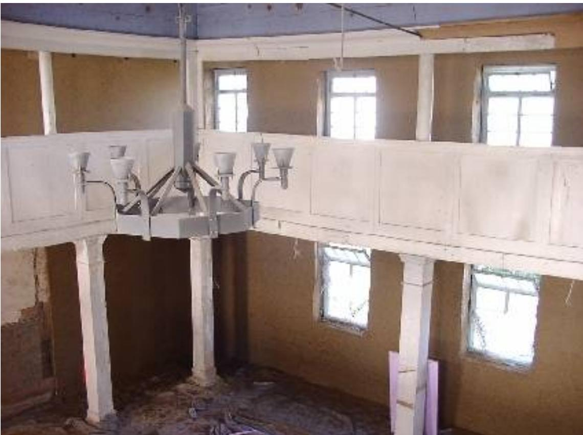
**Abb. 36:** Der neue Lehmputz ist im Innenraum aufgebracht
