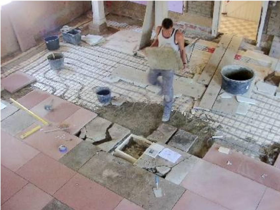
**Abb. 35:** erhaltenswerte alte und neue Fußbodenplatten werden gemäß dem historischen Spiegel verlegt, Bodenheizung
