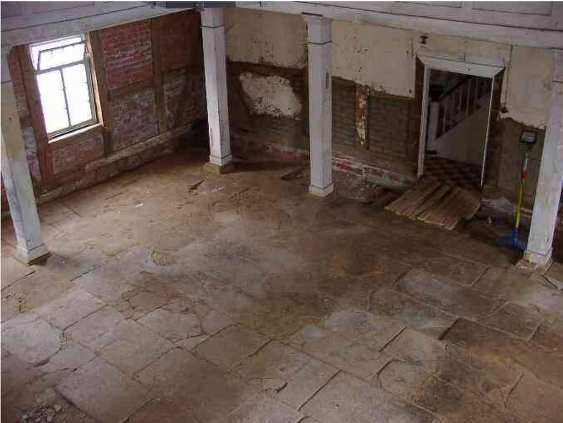
**Abb. 31:** Der Sandsteinboden der Synagoge im Frühjahr 2005 vor der Restaurierung: Viele Platten sind aufgrund des schlechten Untergrundes zerbrochen.
