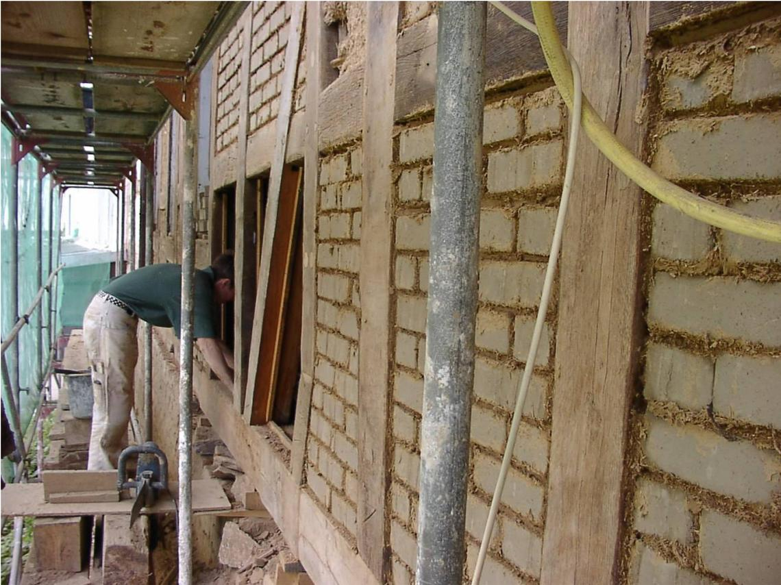
**Abb. 21:** Renovierung der Südwestfassade, Ausfachung mit Lehmziegeln
