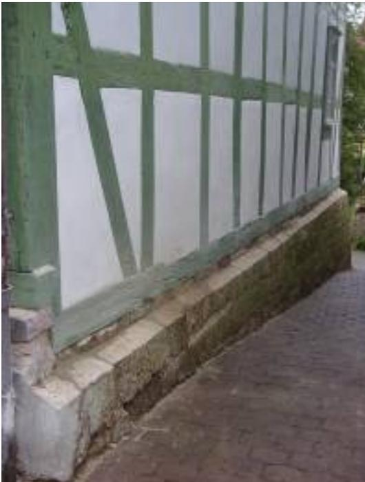
**Abb. 29:** Fertig renovierte Fassade mit angeschrägtem Sockel
