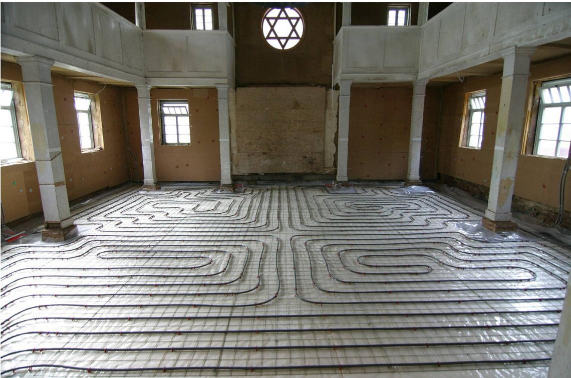
**Abb. 34:** Die Heizschlangen für die Fußbodenheizung sind auf der Betonplatte verankert.
