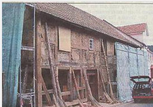
**Mit Balken abgestützt:** Bei der Renovierung der Vöhler Synagoge mussten viele Fachwerkbalken ersetzt werden.
