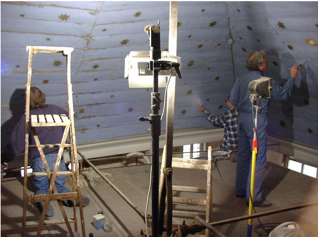
**Abb. 18:** von links: Restaurator Kowal, Assistent and Chef-Restaurator Lausmann an der Arbeit. Lose Farbpartikel werden mechanisch entfernt, die Nagelköpfe gegen Korrosion behandelt und Farbfehlstellen sorgfältig ausgetupft.
