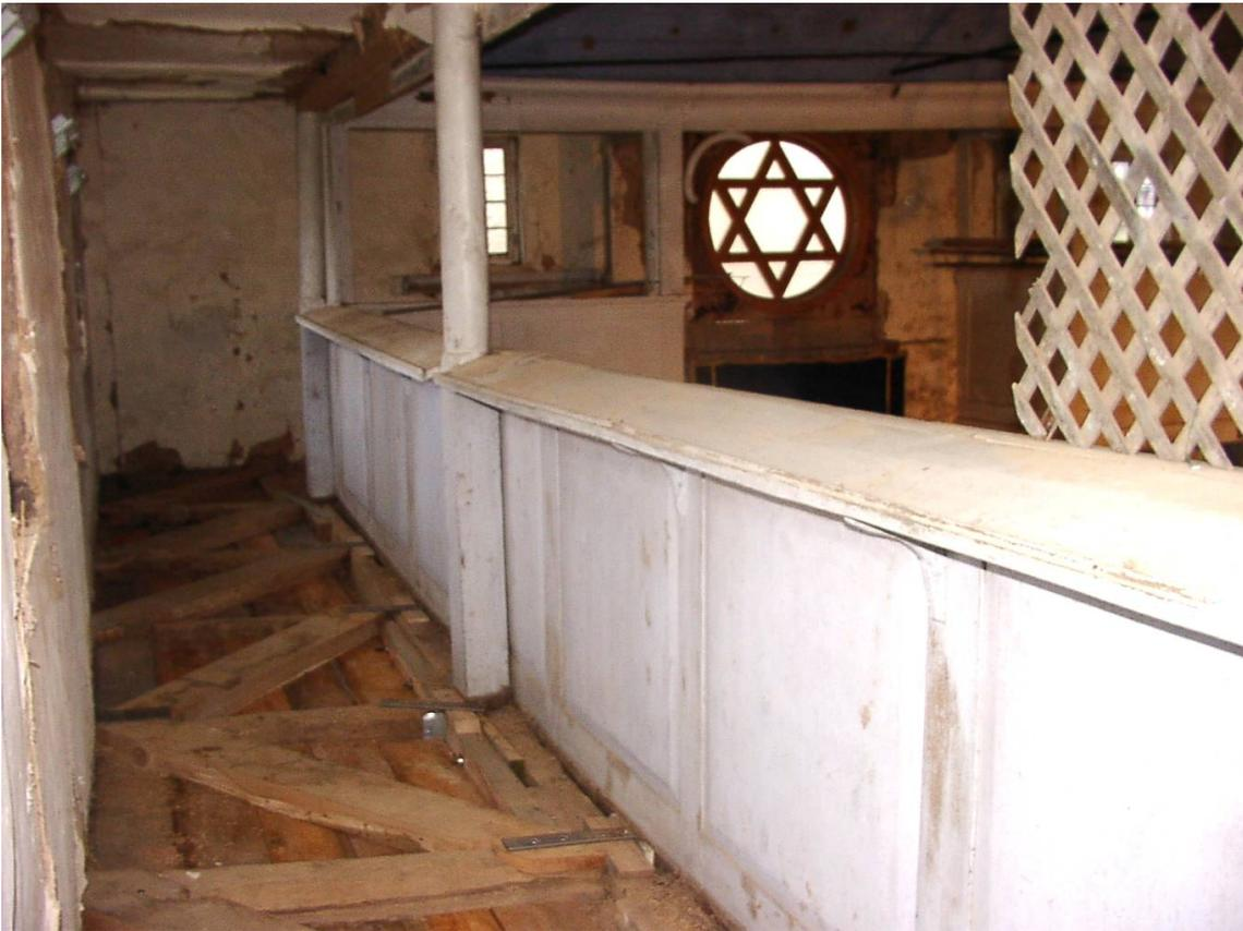
**Abb. 23:** Die Statik der Empore wird durch den liegenden Verband verbessert.
