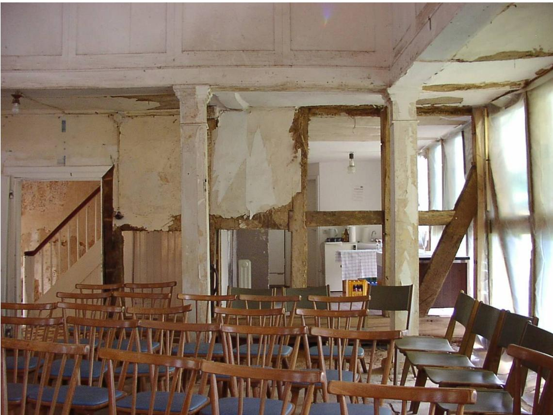
**Abb. 22:** Auch in der zentralen Innenwand sind Balken extrem geschädigt und müssen ausgetauscht werden. Trotzdem finden weiterhin Konzerte statt.
