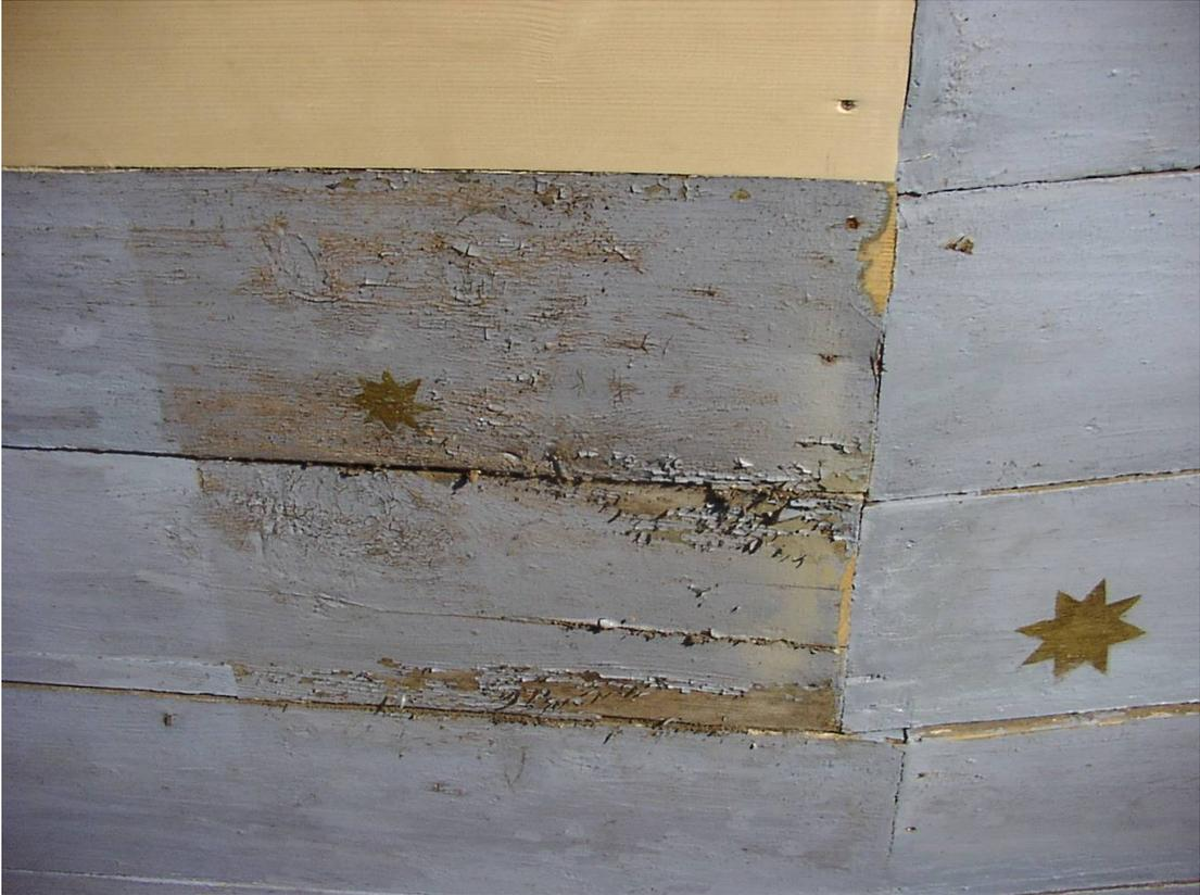
**Abb. 19:** Vergleich einer noch nicht restaurierten mit fertigen Flächen, links oben ein neu eingesetztes Brett.
