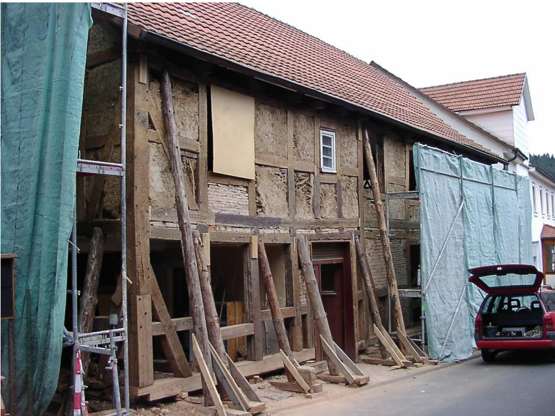
**Abb. 11:** Die Synagoge im Sommer 2002. Zahlreiche Balken, u. a. fast alle Schwellen, mussten auf Grund ihres hohen Schädigungsgrades ausgetauscht werden, von der links verdeckten Nordwestfassade (= Wetterseite) ca. 80%.
