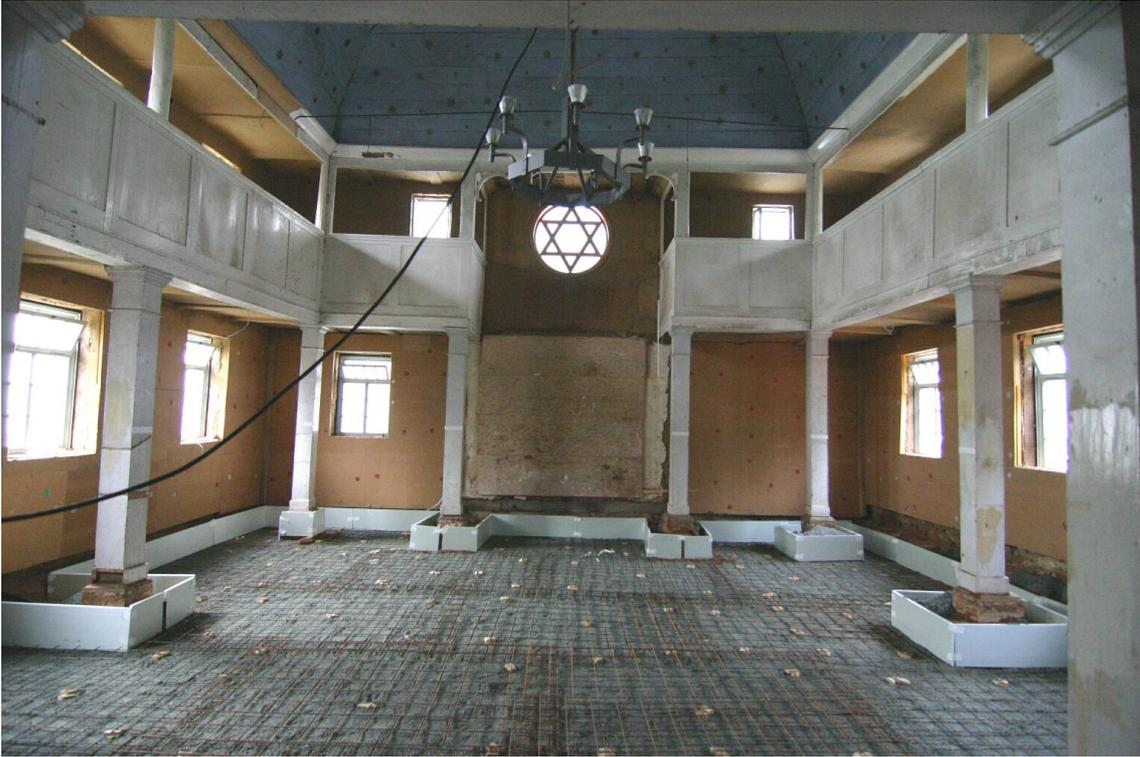
**Abb. 33:** Vorbereitungen für das Gießen der Betonplatte, die zukünftig einen festen Untergrund für Fußbodenheizung und Sandsteinboden bieten wird.
