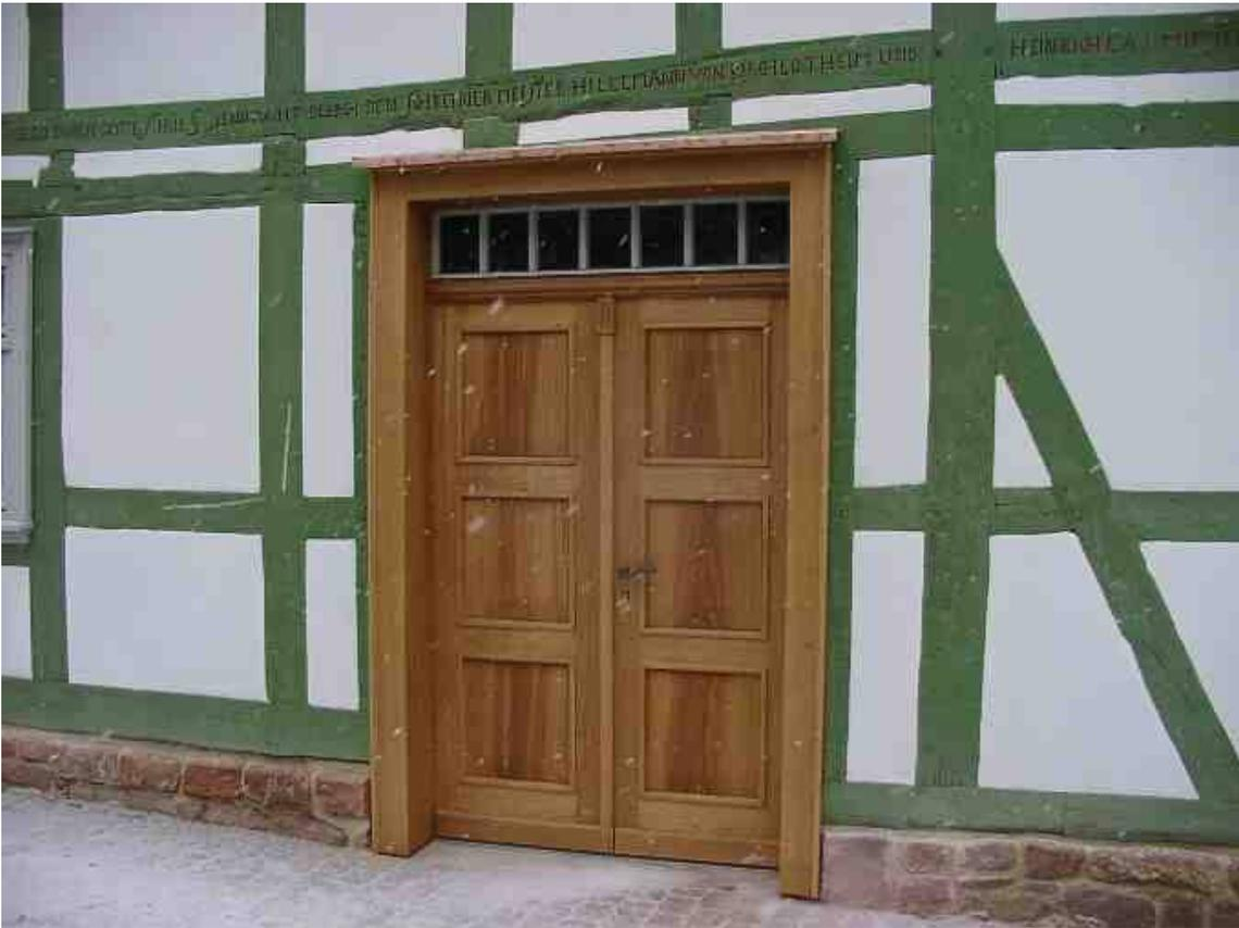
**Abb. 25:** Im Dezember wird die neue, nach historischem Vorbild angefertigte, Eingangstüre eingebaut.
