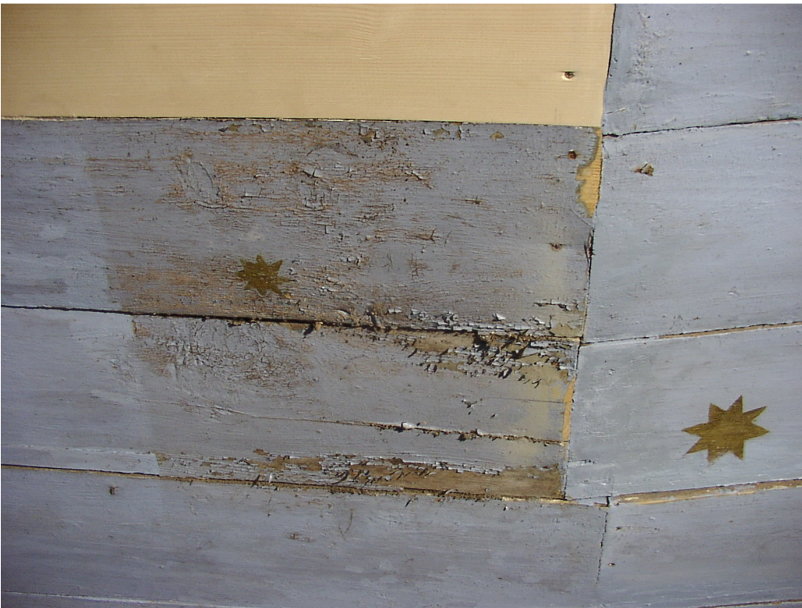
Neu eingesetztes Brett, restaurierte und unrestaurierte Fläche (7. Oktober 2003; Foto: Julius )
