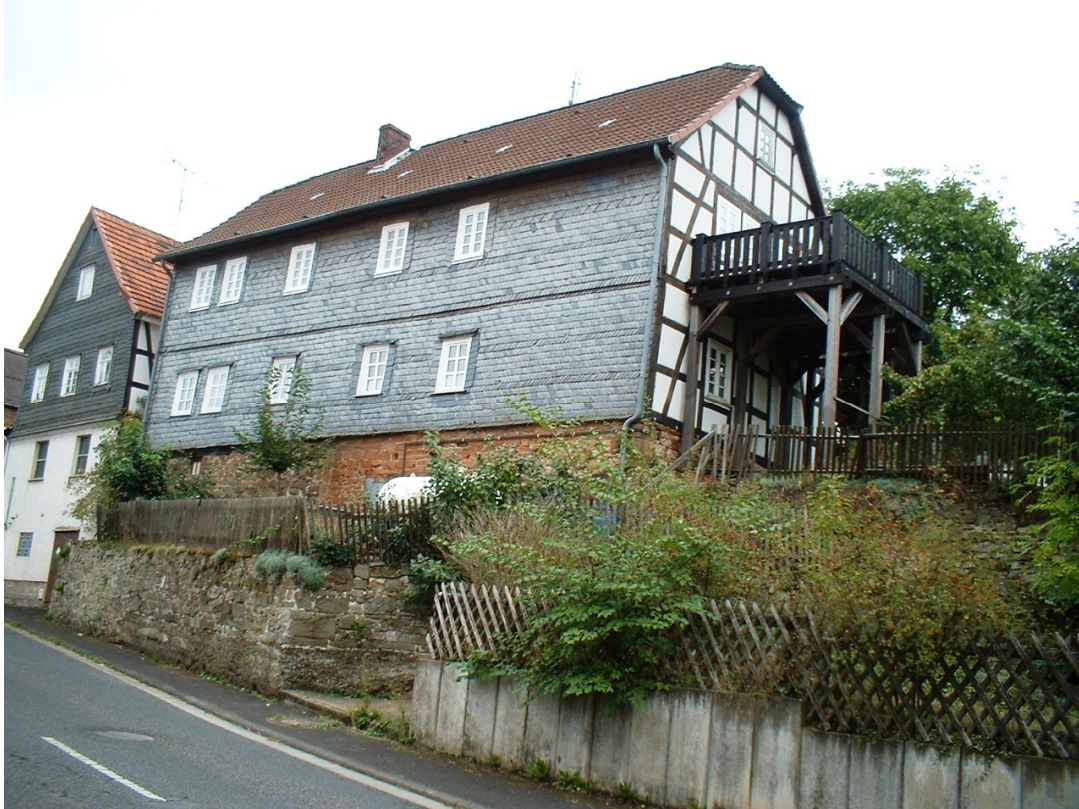
Dort, wo vor dem Haus der Garten zu erkennen ist, befand sich früher einer der Dorfbrunnen (vgl. 1862). (Foto: Walter Schauderna)
