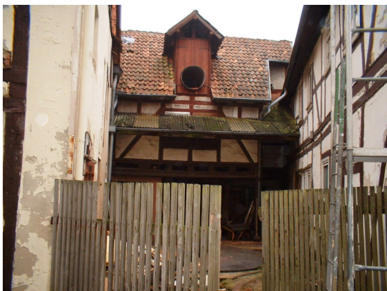
Zwischenbau des Hauses Hirsch in Sachsenhausen
