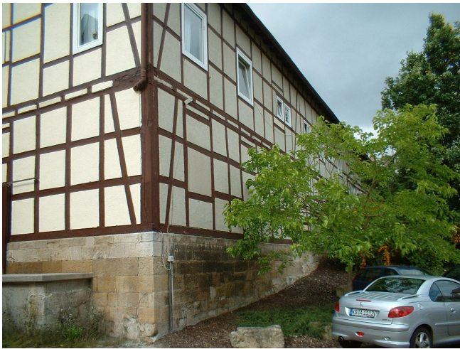
Haus Lengfelder Str. 11 (Seitenansicht)
