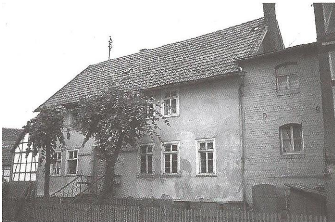
Das ehemalige Haus Bachenheimer im Muschelweg 2 in Röddenau, um 1950 (Foto: Georg Klotz, Marburg)
