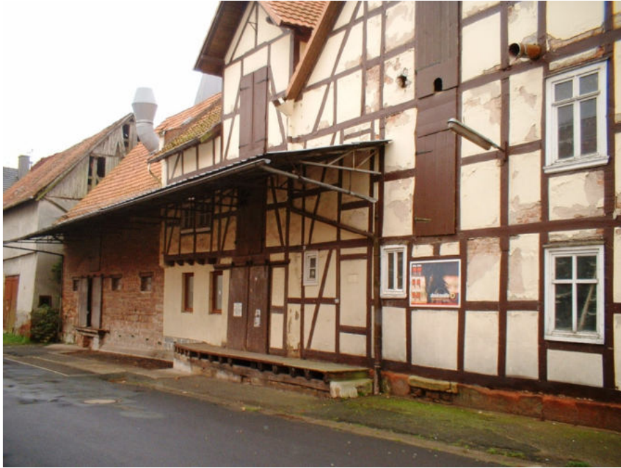
Hinterhaus des Hauses Hirsch in Sachsenhausen (Foto: Stadtler 2008)
