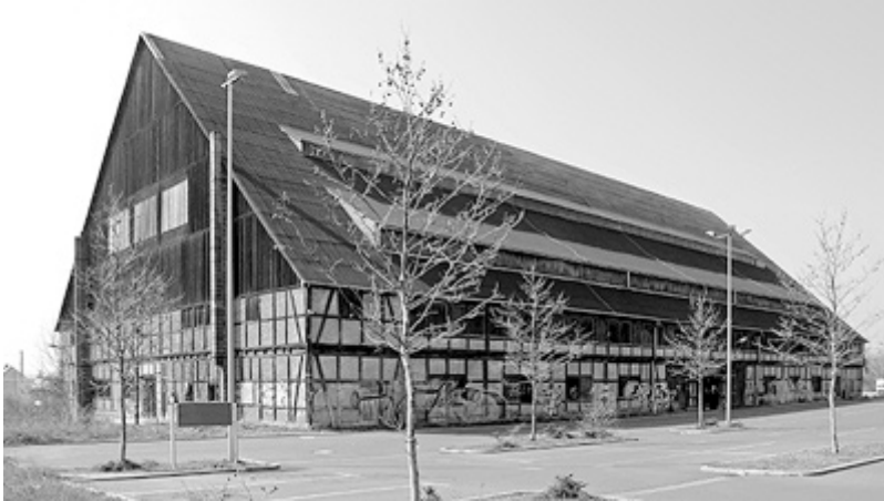
Viehhauktionshalle in Weimar 5
